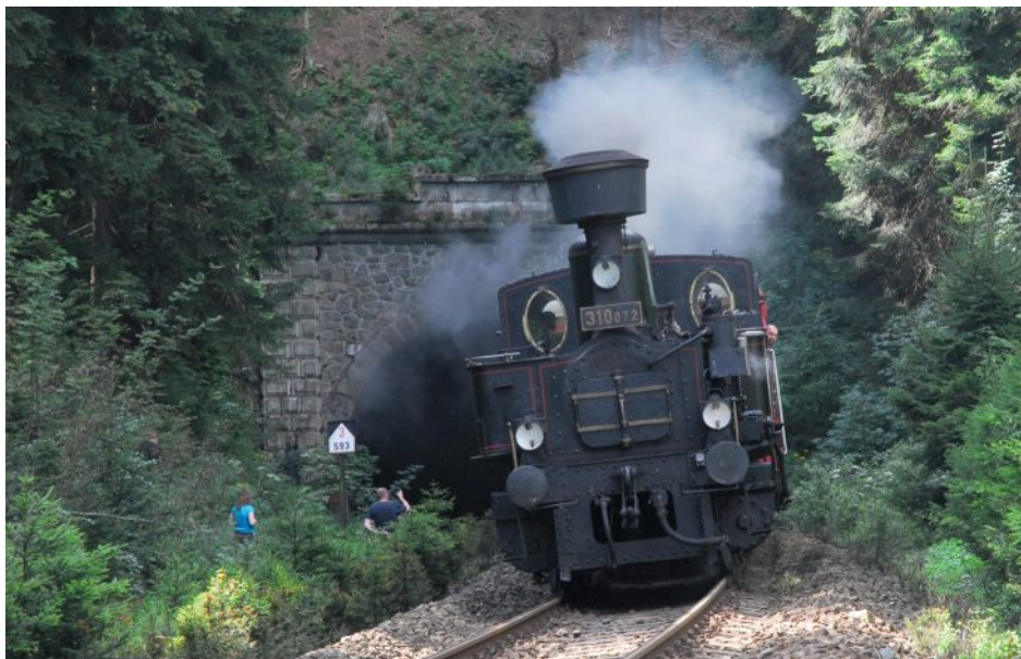
Špičácký tunel - severní portál
