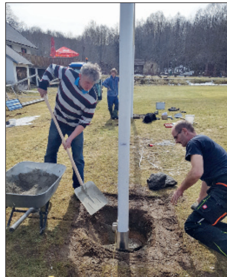
Instalace nových branek před jarní částí
