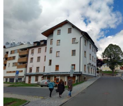
Pohled na objekt z nižší úrovně terénu
