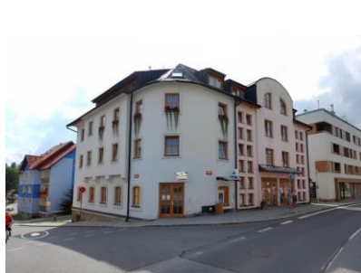
Pohled na objekt z vyšší úrovně terénu
