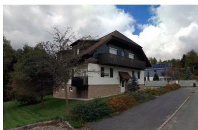
Pohled na objekt z vyšší úrovně terénu
