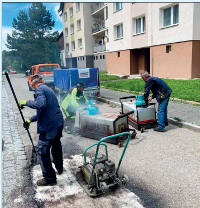
Oprava silnice infrasetem
