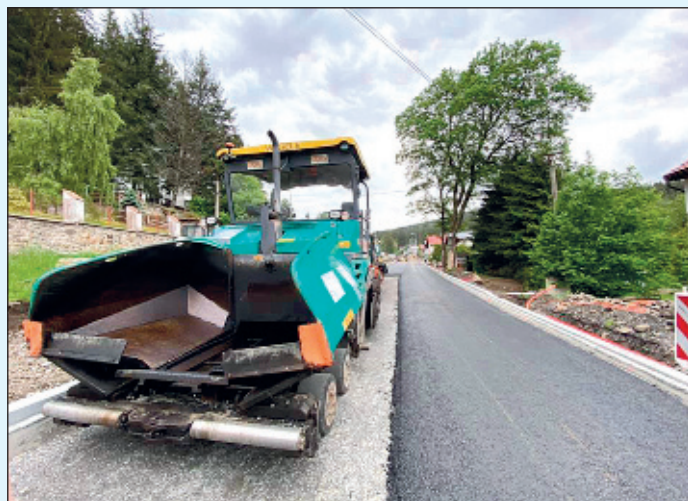
Asfaltování průtahu
