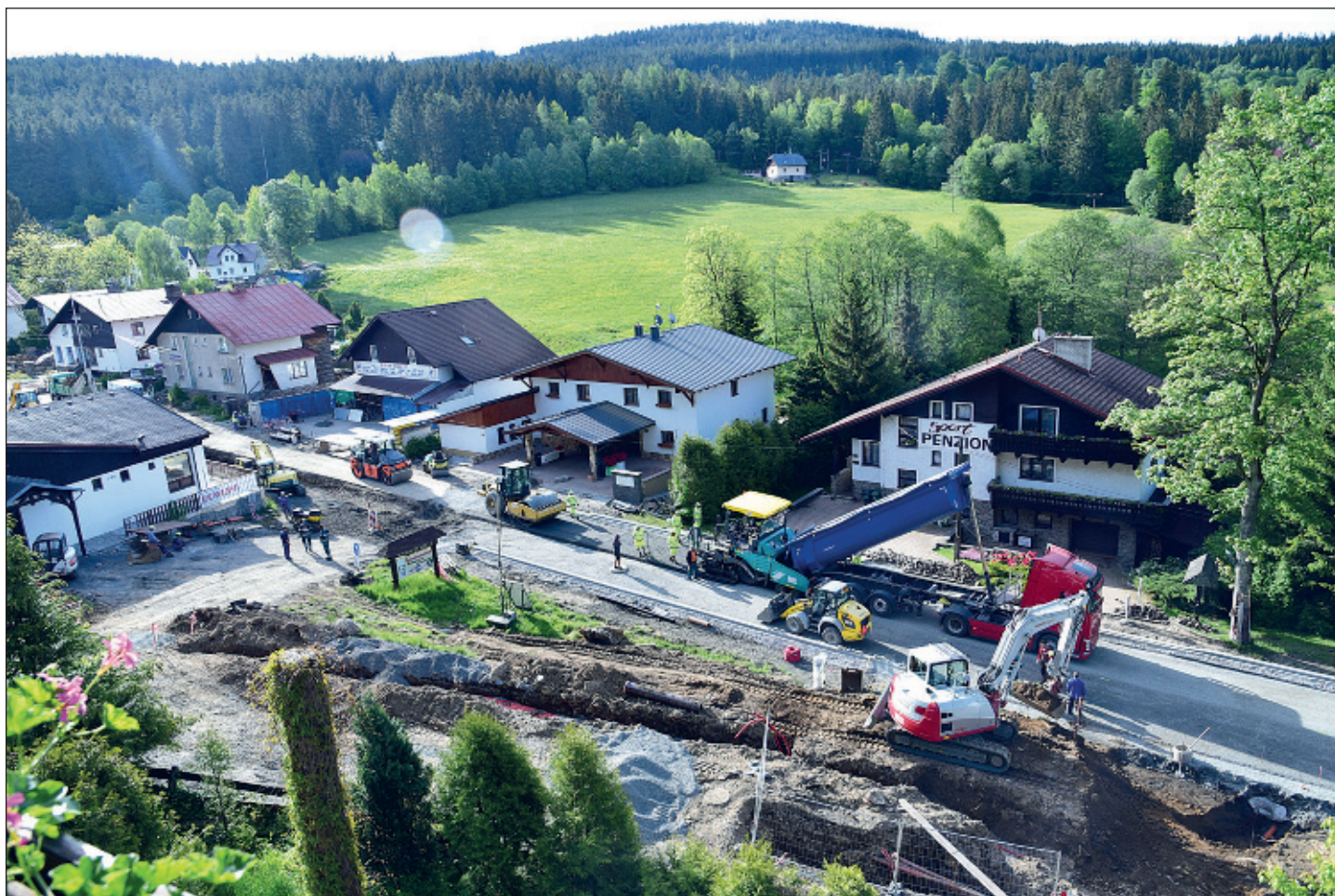
Část Klatovské ulice již začíná připomínat silnici, horní část však teprve na to hlavní čeká. Zemní práce v přilehlém okolí jsou monstrózní.
