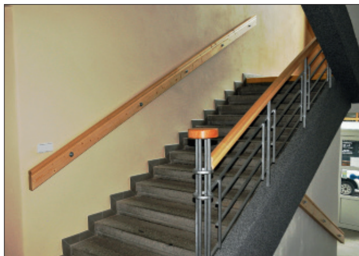
Radnice se chlubí i novým zábradlím uvnitř budovy.
