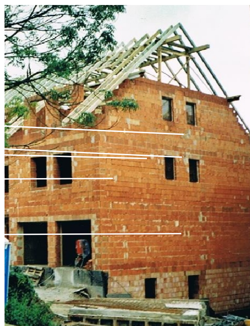
Foto průběh výstavby západní štít čp.408 pořízeno 28.8.2001 č.2
