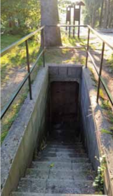
Foto: Trasa Belveder - vstup do bunkru
