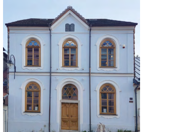
Foto: Synagoga v Hartmanicích
