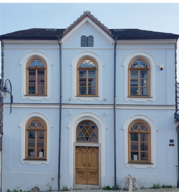
Foto: Bergsynagoge in Hartmanice
